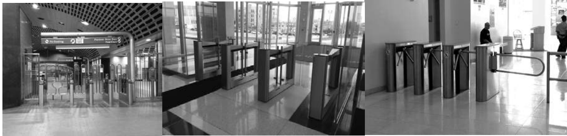
شکل ۶-۱۲- نمونه‌هایی از دوازده‌های کنترلی گردان
